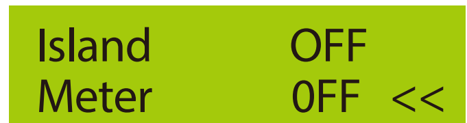
Figura 7.35 Interruptor do medidor
